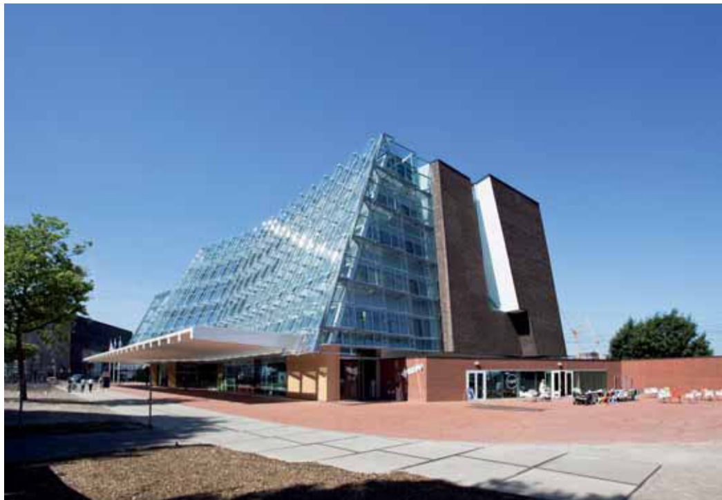
De hellende glasgevel is dubbel uitgevoerd (spouw van twee meter). Samen met de achterliggende vide is deze gevel het 'kloppend hart' van de natuurlijke ventilatie.
